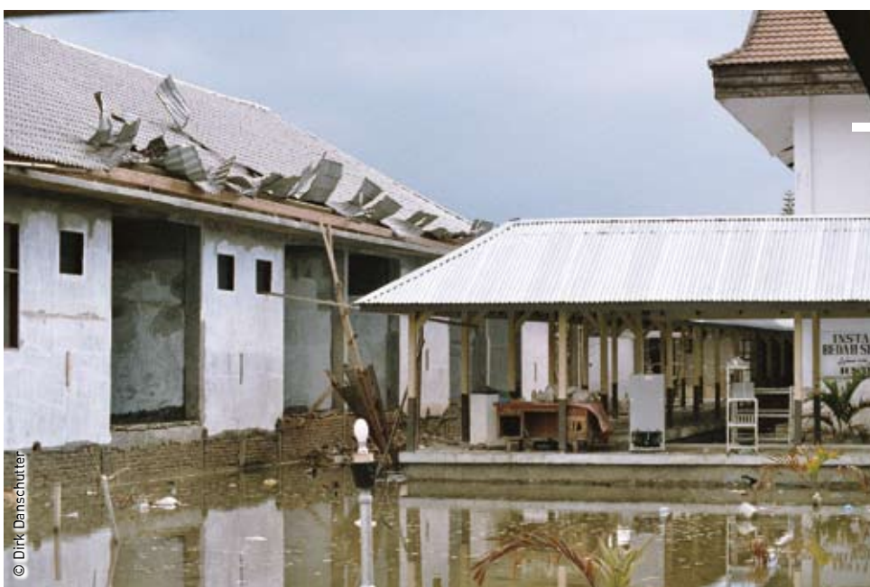
Hoge waterstand en door de tsunami beschadigde paviljoenen van het RSUZA.
